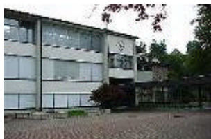
Schulhaus Mösli A
